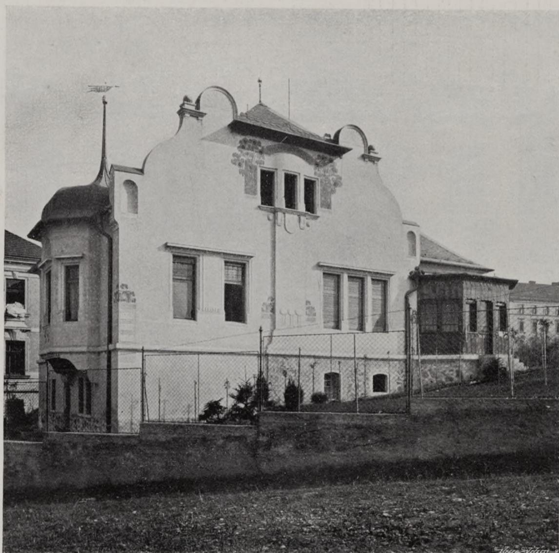
VILLA NA LETNÉ. ZAHRADNÍ FAÇADA.
